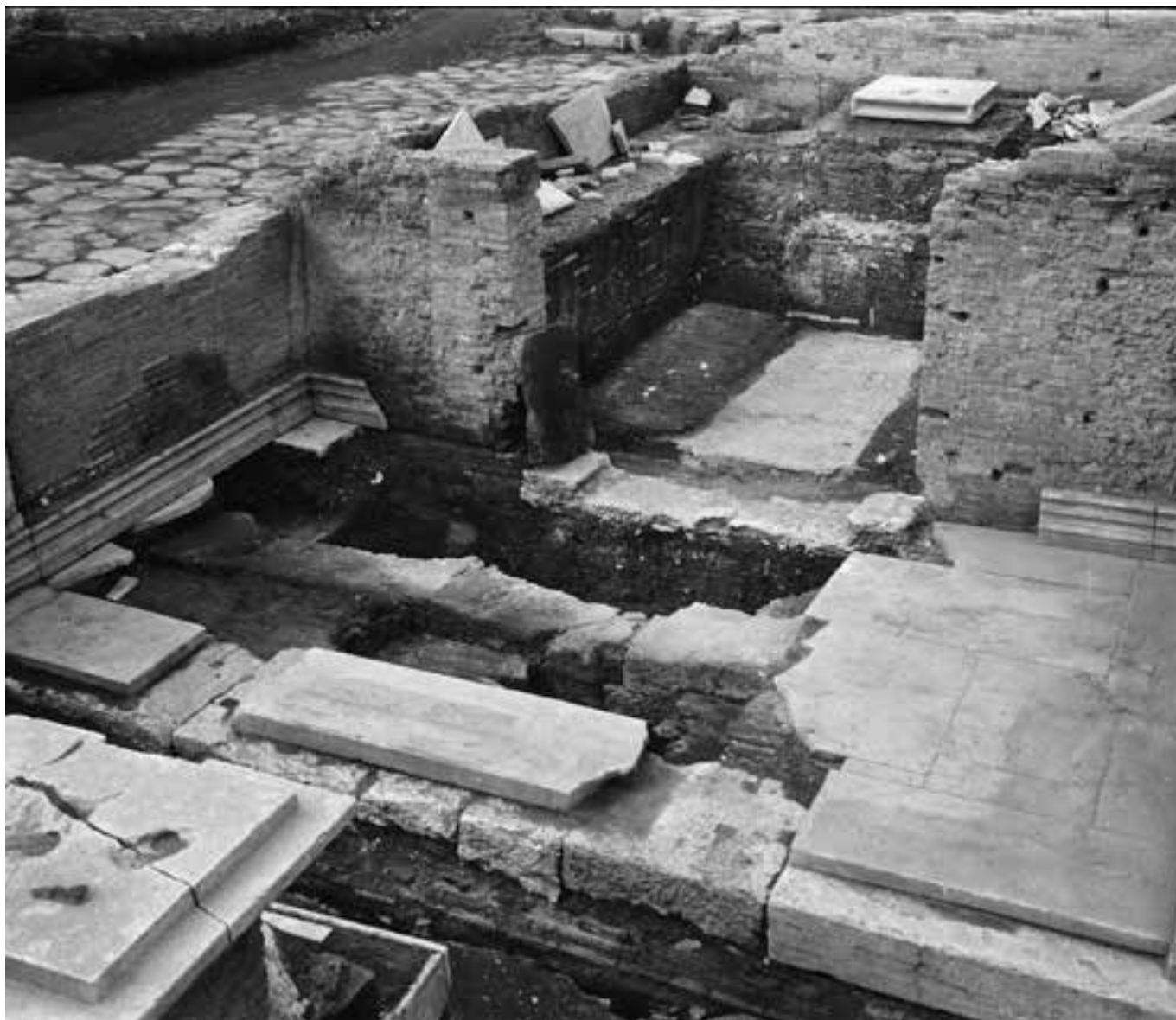
6. Ostia. Veduta della via della Foce dopo il restauro del Tempio dell'Ara rotonda. Si vede in fondo una frattura nel basolato che evidenzia l'abbassamento parziale della strada (Parco archeologico di Ostia antica, AF n. B2932)
