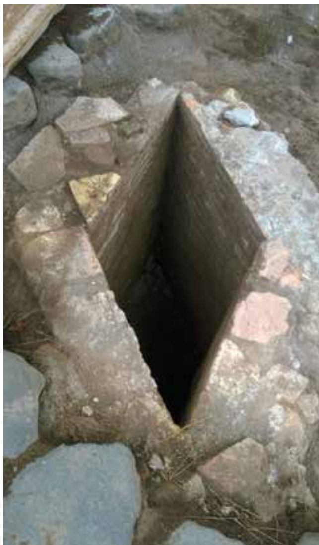
4. Ostia. Imboccatura del pozzetto di ispezione delle fognature di epoca domiziana riscoperto tra il cd. Portico del tetto Spiovente e le Terme del Nettuno (foto Archivio Parco Archeologico di Ostia antica)
