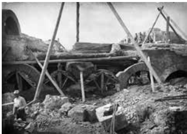
5. Ostia. Casggiato degli Aurighi, 1938: ricostruzione e consolidamento di murature (Parco archeologico di Ostia antica, AF n. B 2632)
