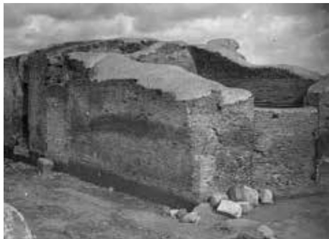
2. Ostia, Caserma dei Vigili. Coperture in cocciopesto dei primissimi anni del '900 (Parco archeologico di Ostia antica, AF n. B1968)
