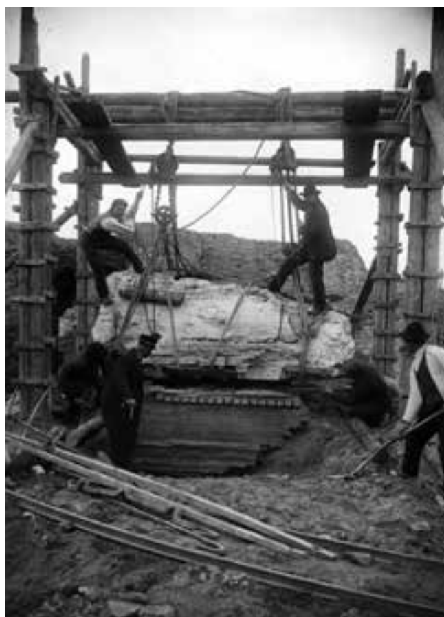
3. Scavi di Ostia, sollevamento di un frammento del cornicione del Teatro, dicembre 1912 (Anonimo, Negativo alla gelatina, 13x18. Parco archeologico di Ostia antica, AF n. B 2060)
