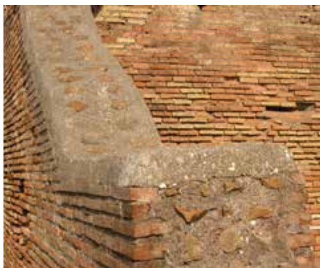
7. Ostia, Caseggiato del Larario, restauri 1967. Coperture in massetti cementizi (foto E. Rinaldi)
