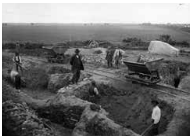
6. Scavi di Ostia, impiego della ferrovia Decauville sugli scavi. Anonimo, Negativo alla gelatina, 13x18 (Parco archeologico di Ostia antica, AF n. B 2194)
