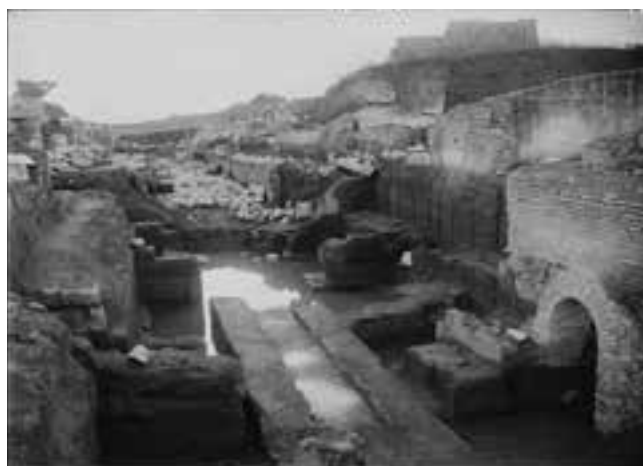
3. Ostia. Veduta del Decumano e della porta orientale del Castrum in corso di restauro in agosto 1914. Si vede in primo piano la fogna con blocchi di tufo che passava tra gli stipiti della porta (Parco archeologico di Ostia antica, AF n. B2199)
