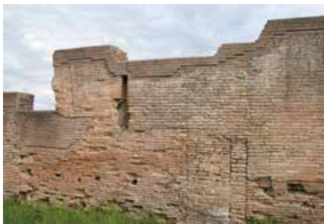
9. Ostia, Fabbricato V VI, 13, restauri 1988. Tecnica di riconoscibilità adottata da V. Mannucci, cd. 'scuretto di demarcazione' (foto E. Rinaldi)
